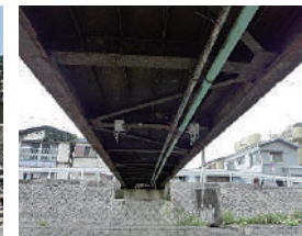
▲橋梁の腐食モニタリング
