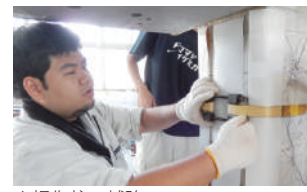
▲損傷柱の補強
